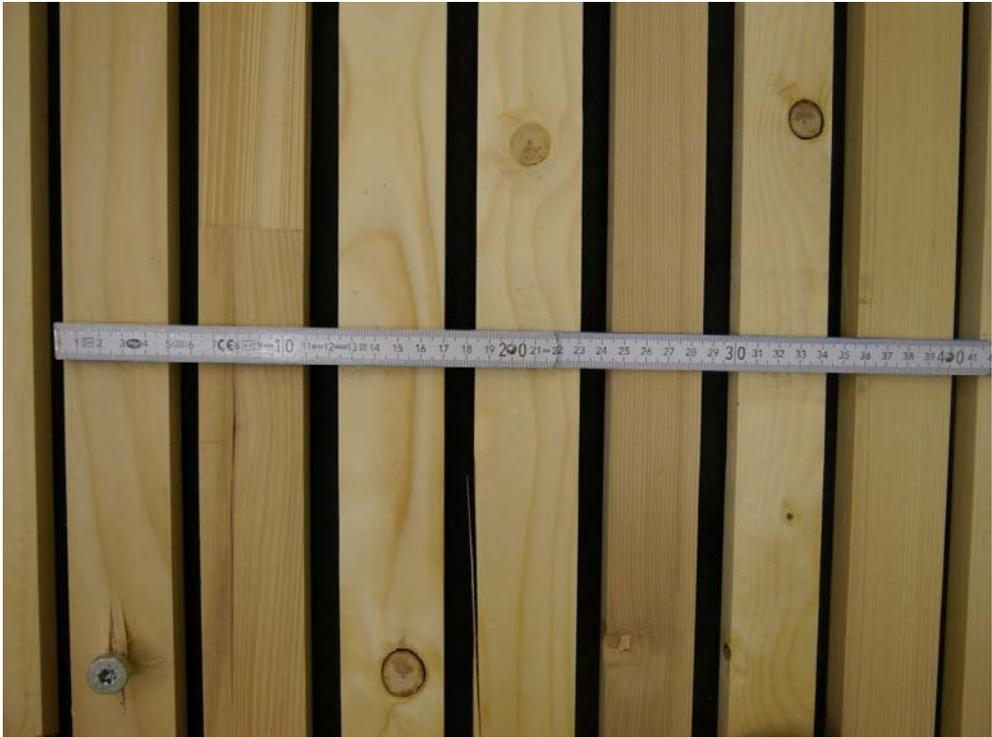
Abbildung B.2. Detailansicht geschlitzte Oberfläche.
